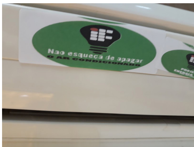
Figura 11 – Avisos no ar condicionado
