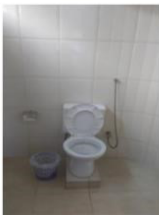
Figura 2: Parte interna do banheiro
