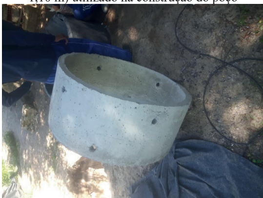
Figura 9 - Anel pré-moldado de concreto perfurado (D = 1,10 m) utilizado na construção do poço
