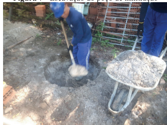
Figura 7 - Escavação do poço de infiltração
