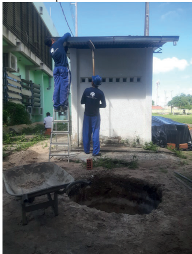
Figura 8 - Colocação da calha no beiral da cobertura
