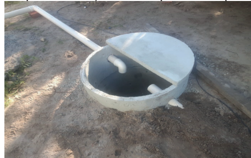
Figura 14 - Poço de infiltração executado, faltando apenas colocação da outra parte da tampa
