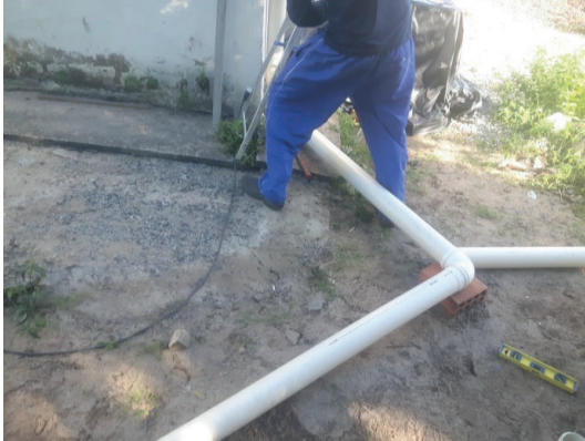
Figura 12 - Instalação dos condutores
