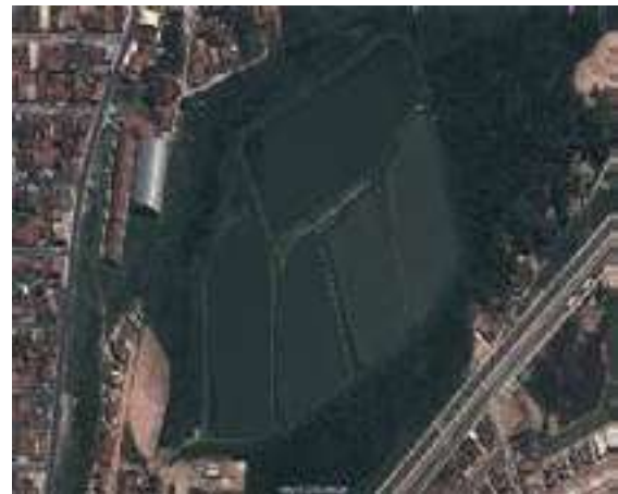
Figura 01 – Vista superior da ETE Rosa Elze.
