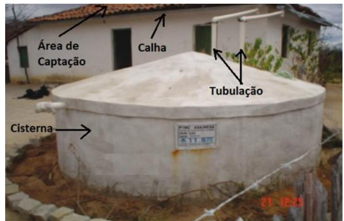
**Figura 2:** Partes de sistema de captação e aproveitamento de água pluvial. **Fonte:** BRASIL (2013)
