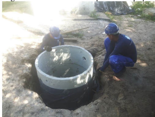
Figura 10 - Operários realizando a colocação da manta geotêxtil externamente as paredes do poço
