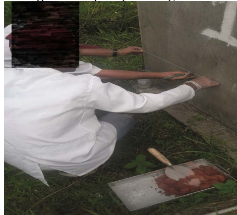
Figura 6 - Aplicação da argamassa.
