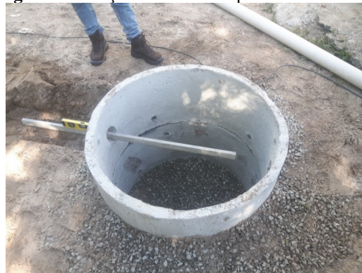
Figura 11 - Poço com brita nas paredes e no fundo
