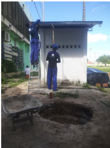
Figura 8 - Colocação da calha no beiral da cobertura
