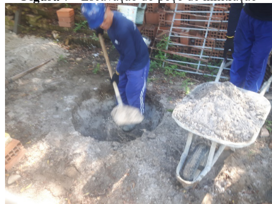
Figura 7 - Escavação do poço de infiltração
