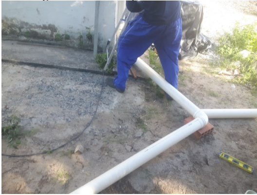
Figura 12 - Instalação dos condutores
