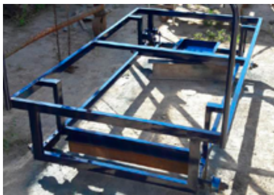
Figura 1 – Montagem da para estrutural do trem.
