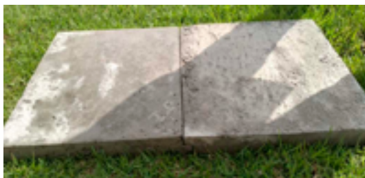
Figura 6 - Verificação dos encaixes Fonte: Autor, 2019.
