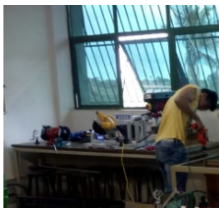
Figura 2 - Instalação dos equipamentos no laboratório de pesquisa em engenharia elétrica
