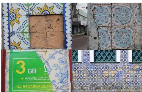
Figura 8 - Degradação dos azulejos em fachadas de Estância.
