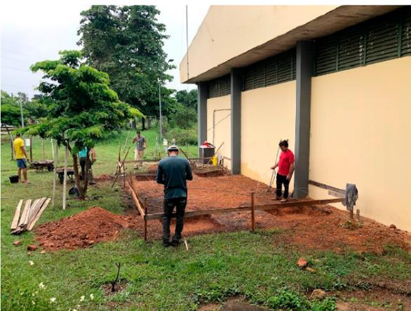
**Figura 03** – Nivelamento do terreno e gabarito da obra
