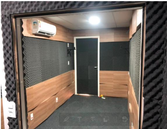
**Figura 07** – Instalação das espumas acústicas.
