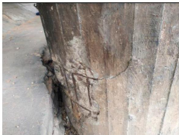
**Figura 3** – Exposição de armadura e degradação do pilar
