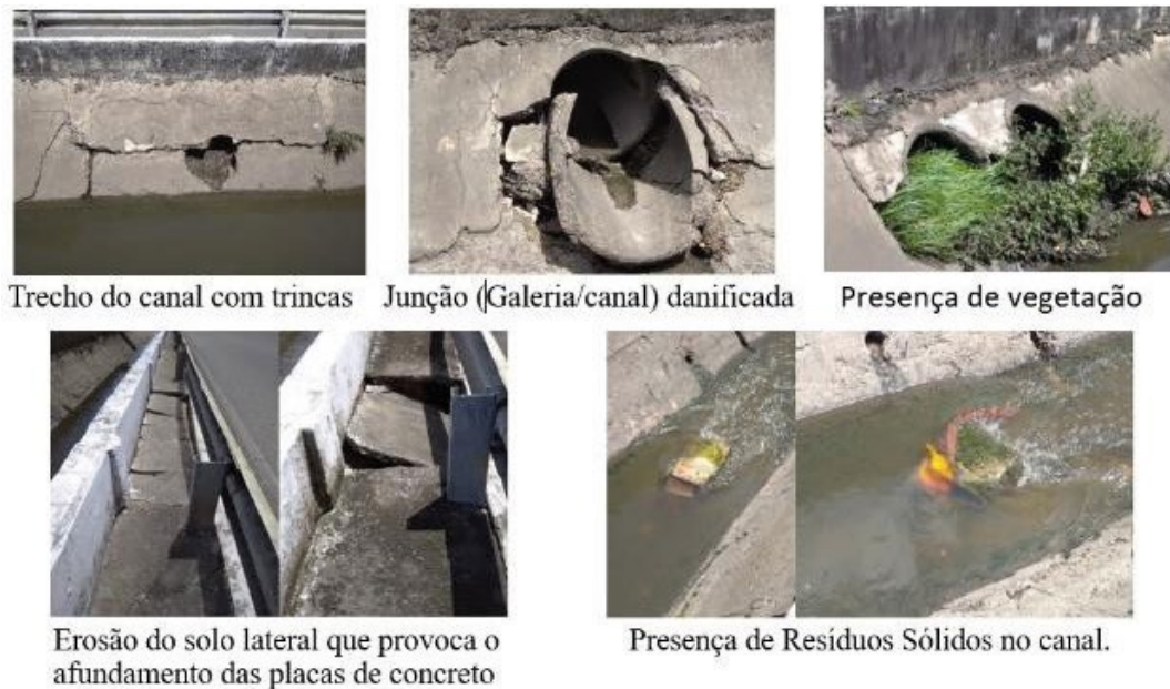
Figura 03 - Patologias do Canal de Drenagem Av. Gentil tavares
