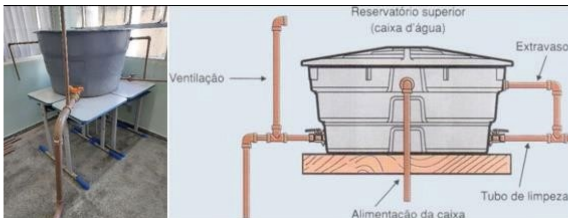
Figura 4 – Reservatório da sala 105 com suas tubulações instaladas
