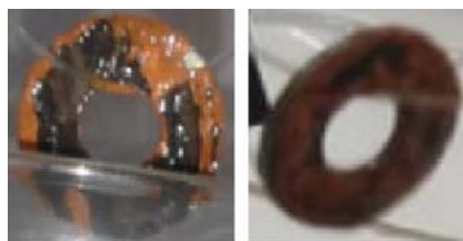
Figura 2 - Arruelas em seu estado corroído ao fim de uma semana: (a) Sistema 4; (b) Sistema 5.
