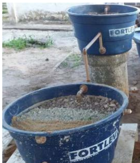
Figura 1 - Disposição do meio filtrante nas caixas d'água.
