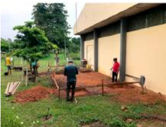
Figura 03 – Nivelamento do terreno e gabarito da obra Fonte: Autor (2019)
