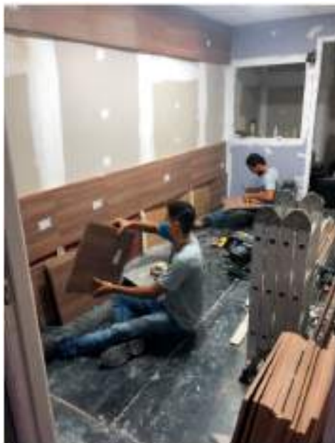
Figura 06 – instalação do drywall e defletores de som. Fonte: Autor (2019)
