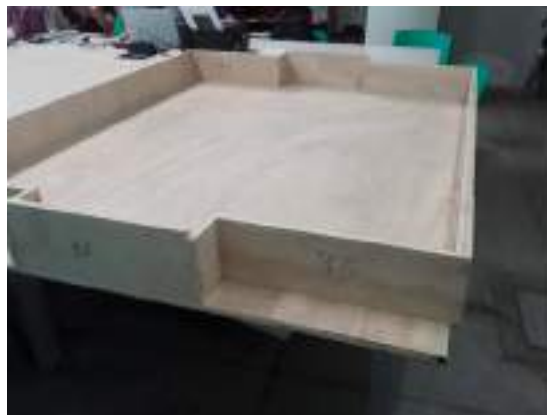
Figura 2 – Vista lateral do campo em processo de construção.
