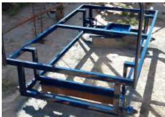
Figura 1 – Montagem da para estrutural do trem.
