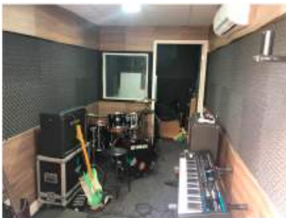
Figura 08 – conclusão da transformação do container em estúdio musical. Fonte: Autor (2019)
