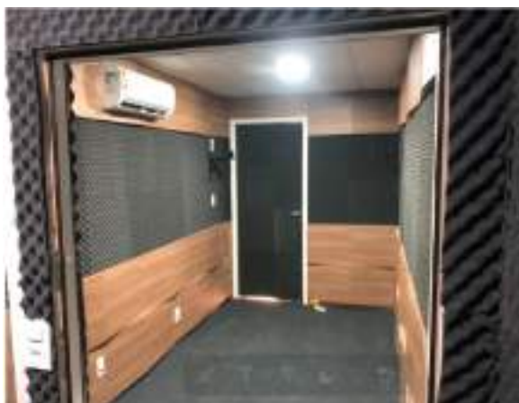
Figura 07 – Instalação das espumas acústicas. Fonte: Autor (2019)
