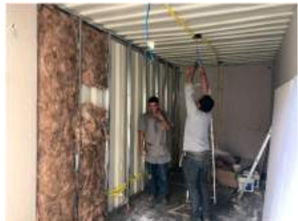
Figura 05 – tratamento termo acústico do interior do container. Fonte: Autor (2019)
