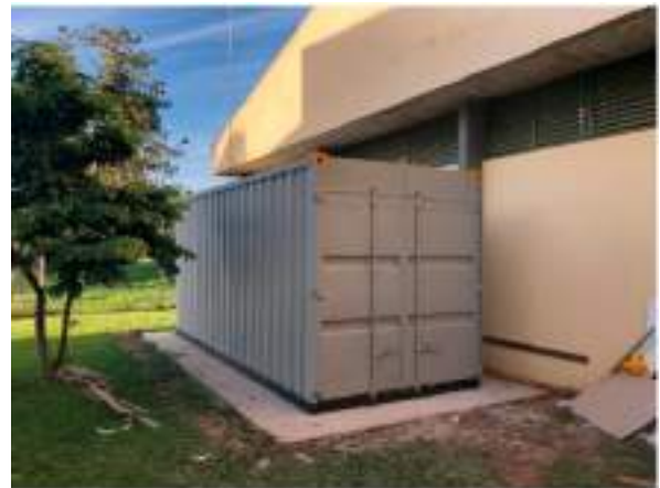
Figura 04 – concretagem da base e locação do Container. Fonte: Autor (2019)
