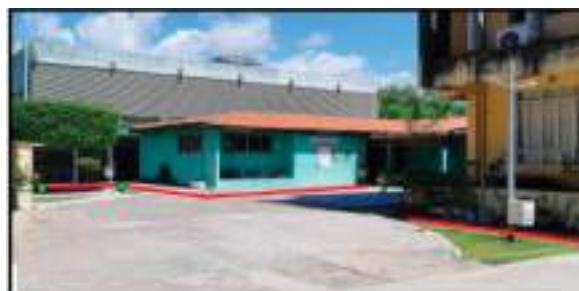
Figura 2: Área de Execução do Espaço de Convivência – área anexa ginásio de esportes
