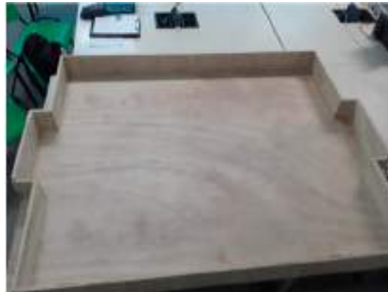
Figura 1 – Vista superior do campo em processo de construção.
