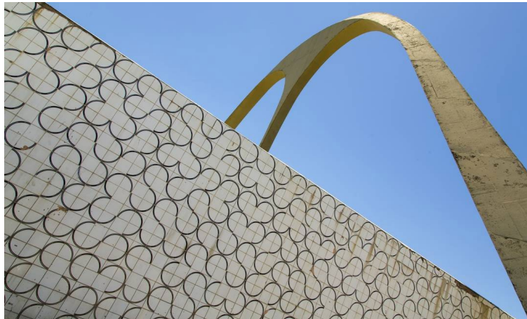
Figura02 - Painel de azulejos, Praça da Aproveitosa, Sambódromo, 1983. Rio de Janeiro, RJ
