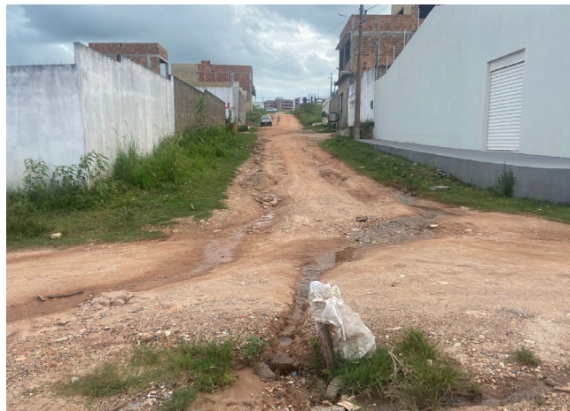
Figura 2 - Rua sem calçamento e com falta de saneamento, Novo Horizonte
