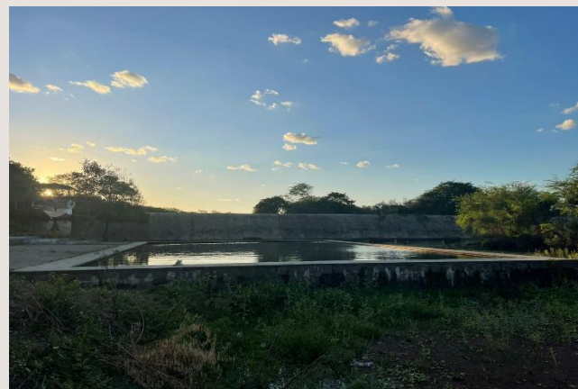
Figura 12: Foto da piscina da Barragem
