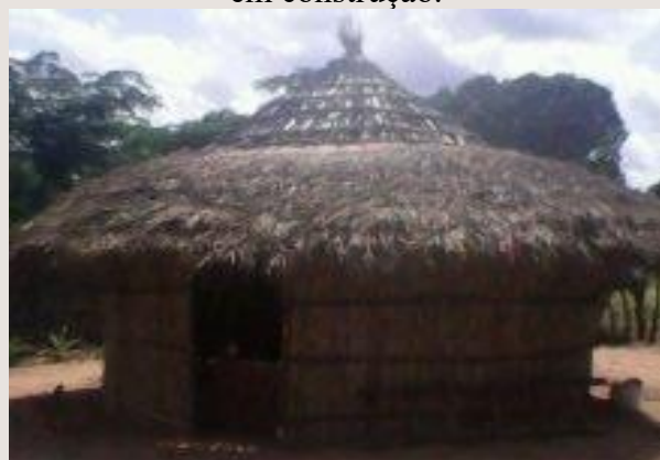
Figura 3 – Yindluyaxitxunga (Casa de palhota) em construção.
